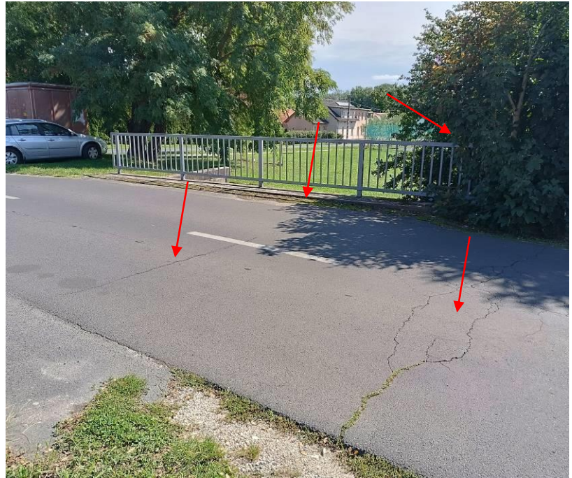
6. és 7. kép: A központ felőli burkolat csatlakozások
