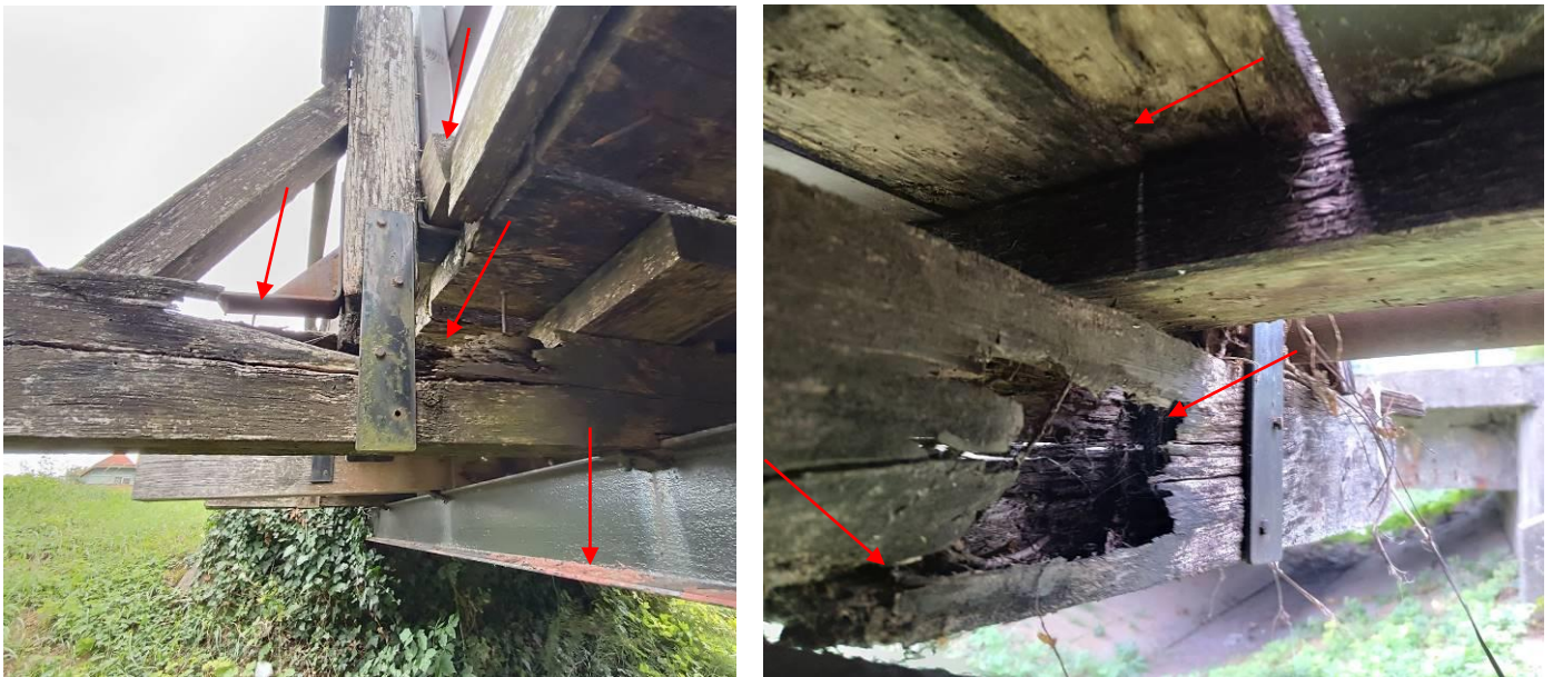
5. és 6. kép: A híd acél és fa tartószerkezete
