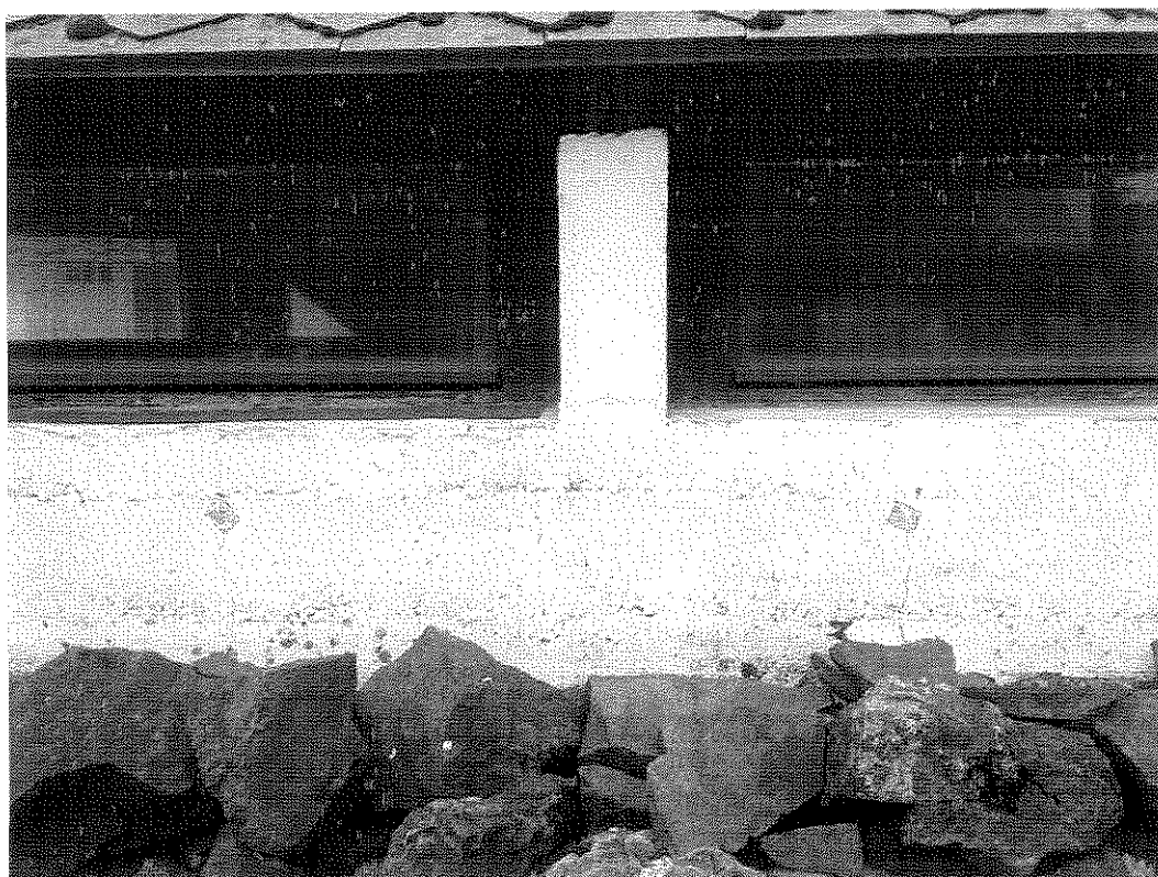
M12: Zsugorodási repedések a vb. alépitményen (általánosan jellemző)
