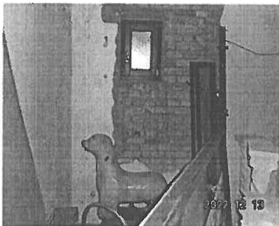
Befejezetlen átalakítási munkák
