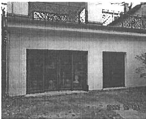
Raktár északi homlokzata
