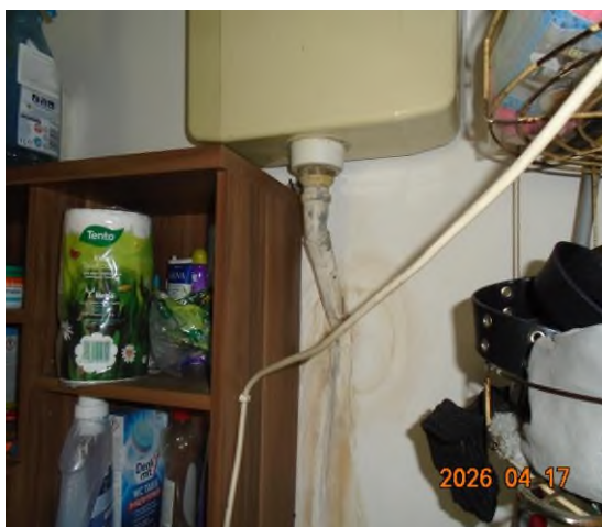
Tönkrement vízvezeték, falázás
