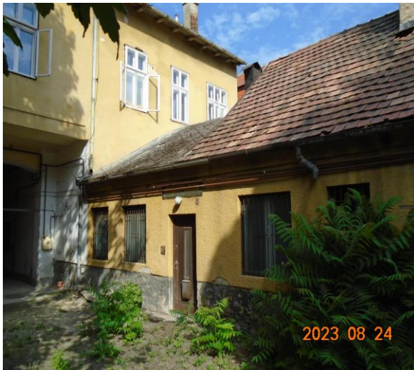
Déli homlokzat, bejárat
