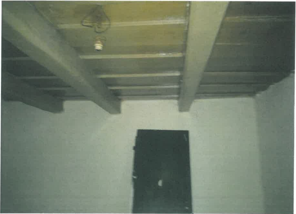
A saroképület belső képe a befalazott ablakokkal.
