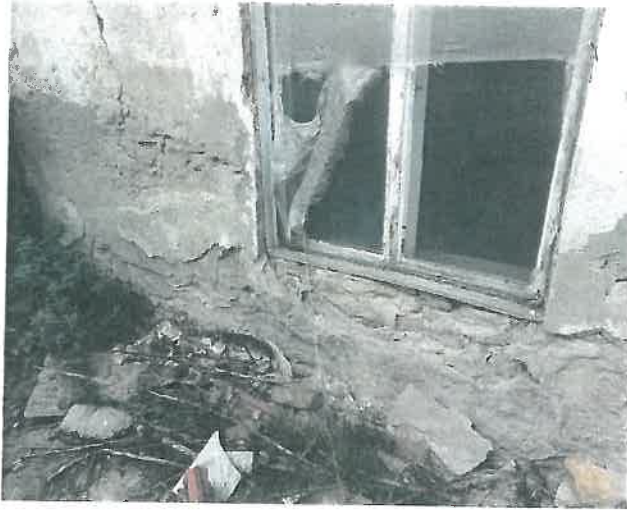
Szigeteletlen, omladozó vegyesfalazat
