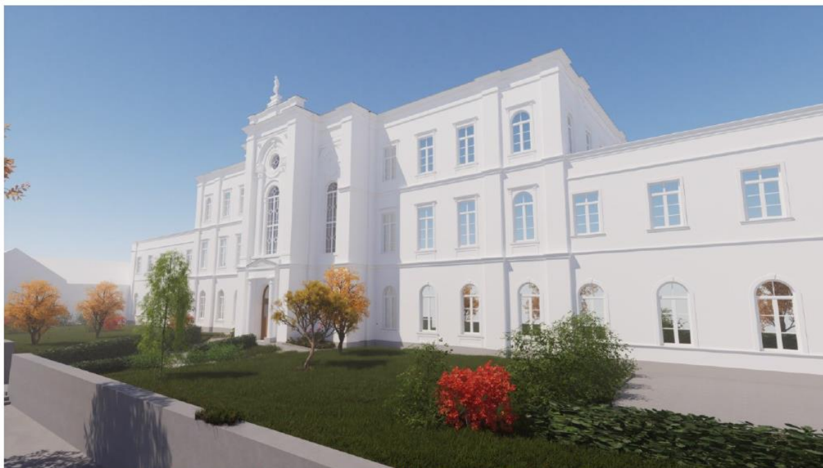
a Ranolder-szárny főhomlokzata a rekonstruált régi főbejárati közép rizalittal, valamint az új Északi bővitménnyel.
