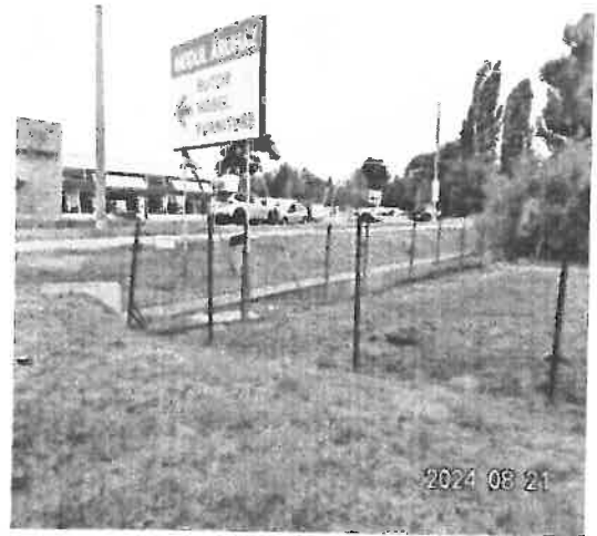
Csapás utcai sarok, szintkülönbség
