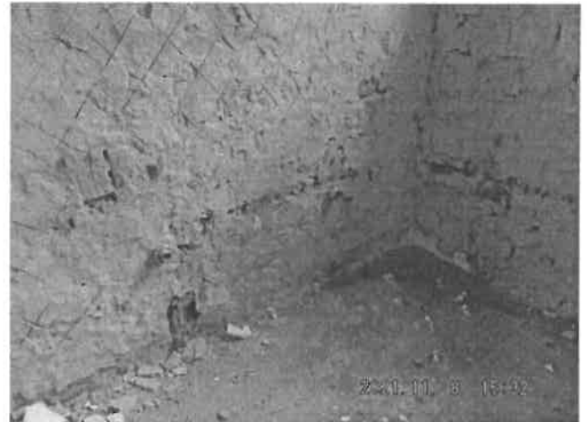
Kibontott vízvezeték rendszer
