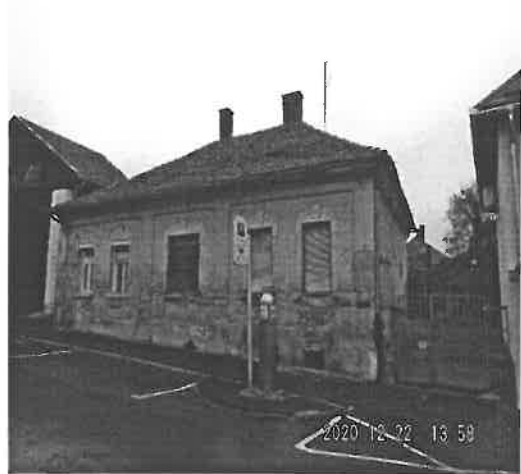
Szalasztó utcai homlokzat
