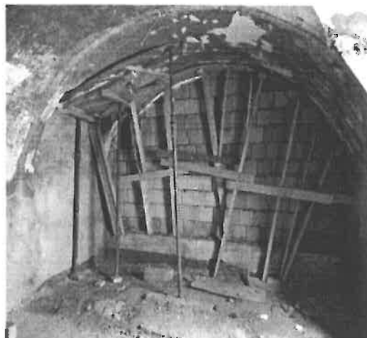
Helyreállított lezáró falazat
