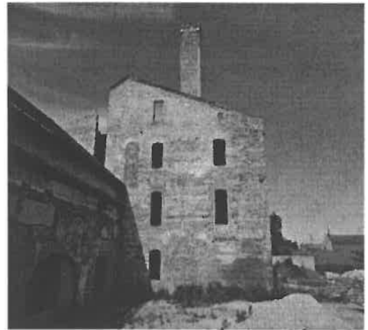
Gépház nyugati homlokzata
