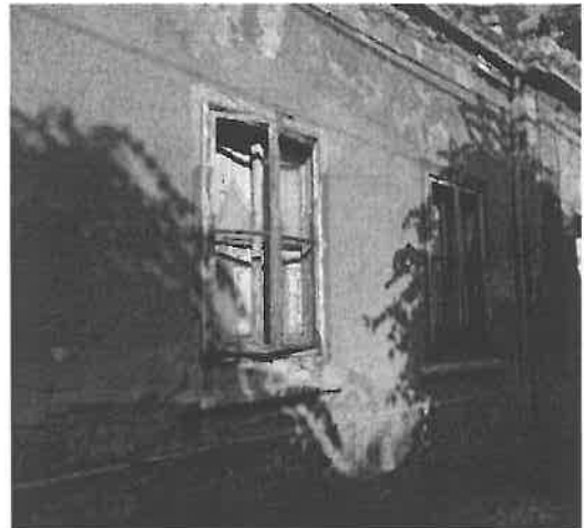
Deák utcai eredeti külső homlokzat ( nyugat )
