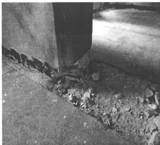
Befejezetlen belső átjáró
