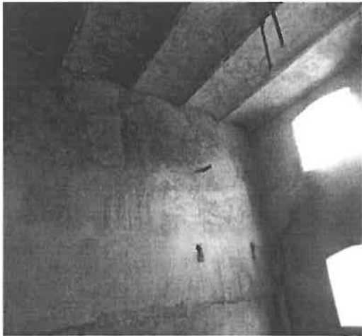
Helyreállított cseh-süveg boltozat
