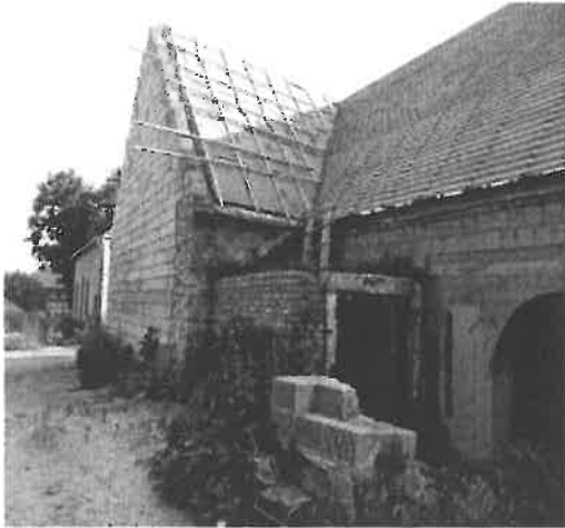
Megerősített falazatok, befejezetlen tetőzet
