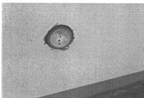
Korábbi konvektor kivezetés helye a homlokzaton
