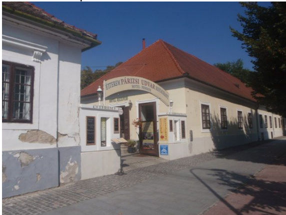
13. Párizsi udvar bejárata 2031 hrsz
